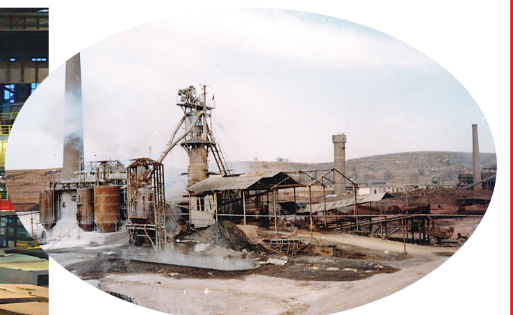
▲ 1994年11月，岚县第二铁厂厂区
