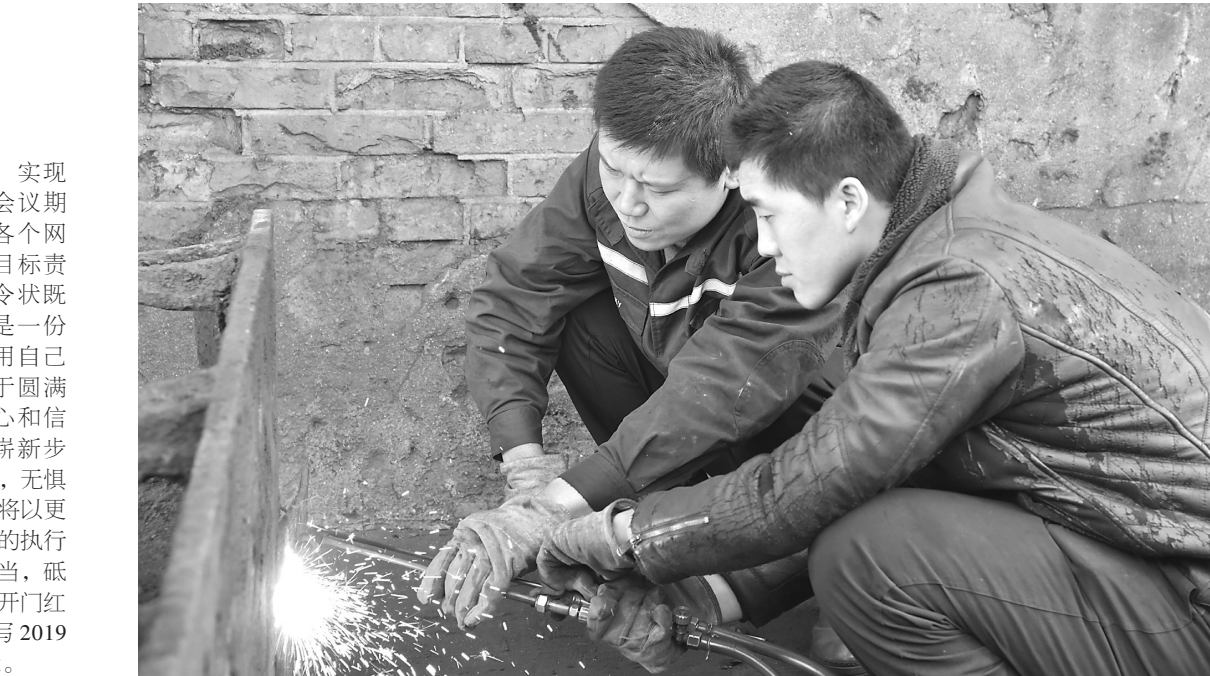
近日,在山西焦煤汾西矿业高阳煤矿机修厂溜子组,两名职工正在维修井下回收挡煤板。结合矿井经营管控实际,高阳煤矿围绕成本精算账、细算账,大力开展修旧利废、五小改革、“金点子”工作,仅修旧利废一项,每年可为企业创收1000余万元。 王小涛 摄
