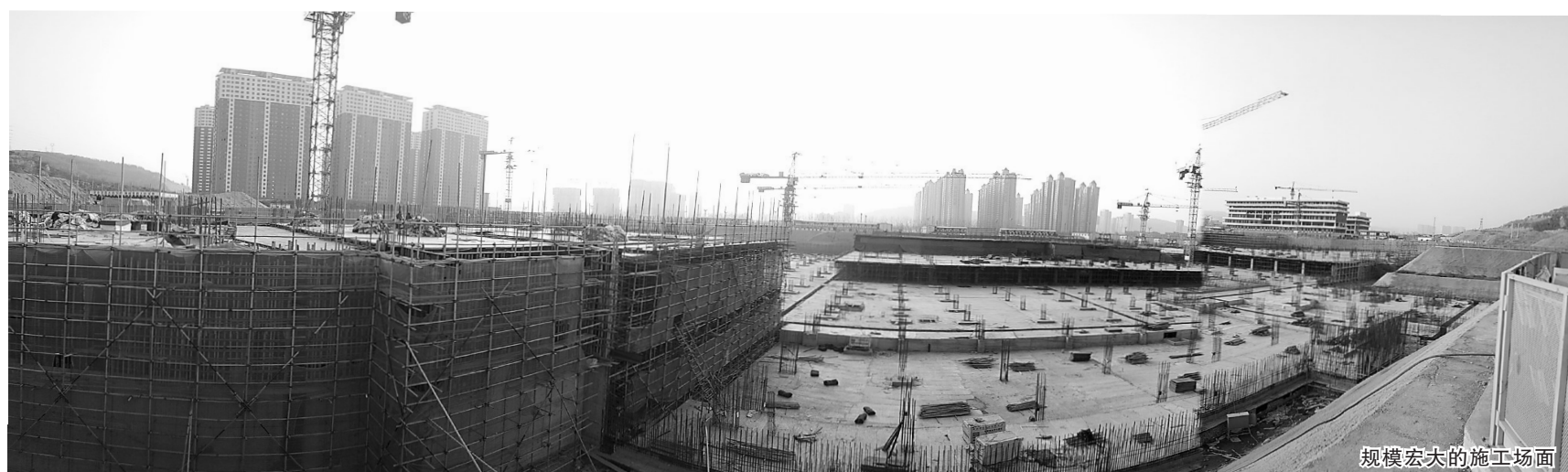
规模宏大的施工场面
