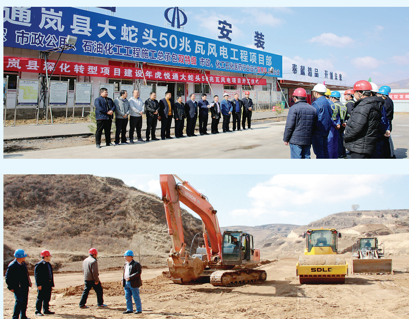
春回大地催人进，追梦前行再出发。4月11日上午，岚县举行深化转型项目建设年集中开工仪式。此次集中开工项目5个，总投资22.7亿元，年度计划完成9亿元，涵盖基础设施项目、社会民生项目等多个领域，这些项目的开工建设，将为全县经济高质量发展提供强有力的支撑。 牛燕飞 程美芳 杨娟娟 摄
