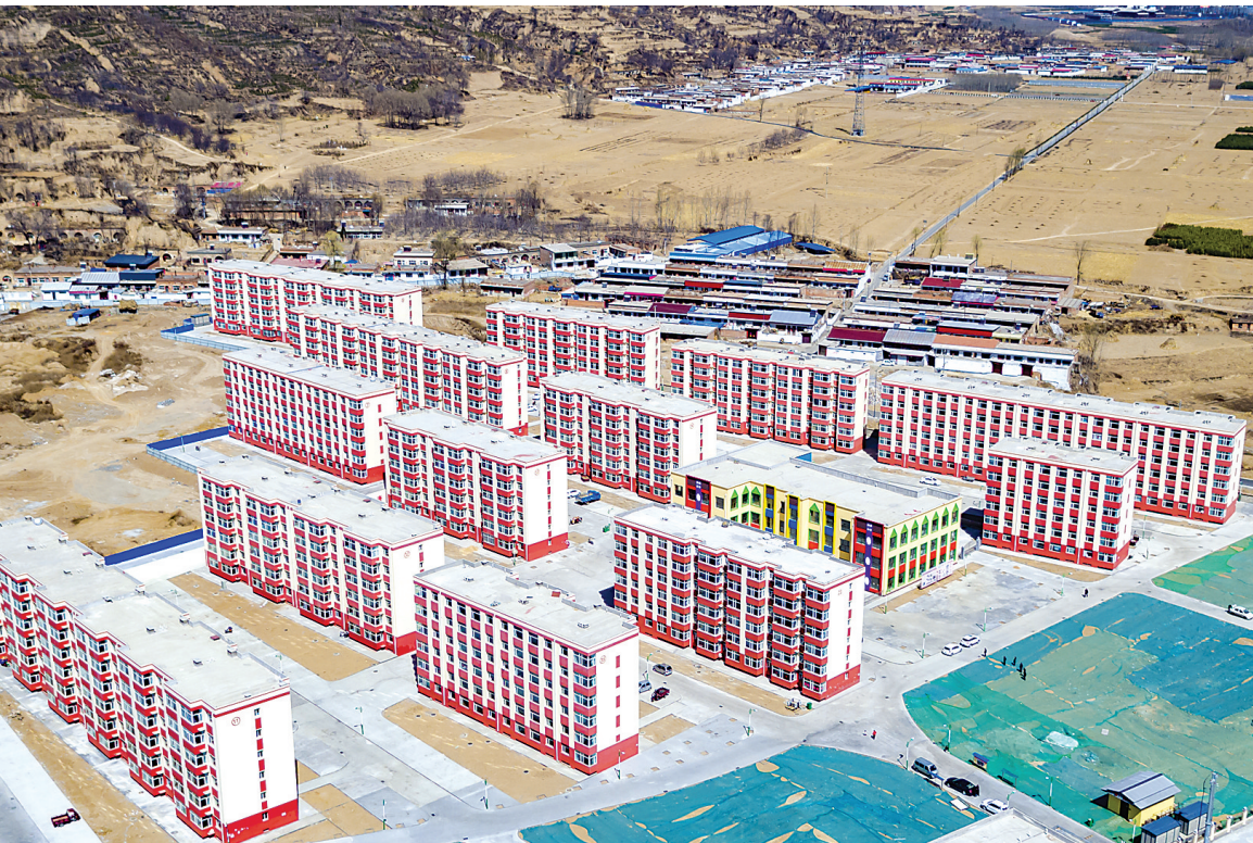
方山区圪洞镇津良庄村易地扶贫搬迁安置点于2017年5月开工建设,2018年10月竣工。安置点涉及搬迁村22个,共安置贫困户858户2149人。项目总投资1.5亿元,占地168.3亩,建设安置楼17栋924套,建筑面积6.5万平方米。配套建设了水、暖、电及广场、幼儿园、超市等基础设施和“三站三室”(党员活动室、乡镇联络站、便民服务站、文化室、医疗卫生室、物业管理室),极大地提升了基础设施和公共服务水平。 记者 刘亮亮 摄
