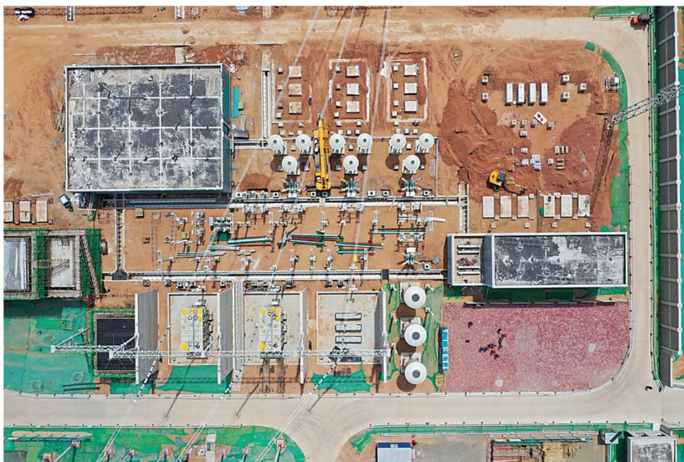
5月8日，工人在位于河北省张家口市康保县姚家滩村的康保换流站施工(无人机拍摄)。正在建设中的张北可再生能源柔性直流电网示范工程包含张北、康保、北京、丰宁四座换流站和直流输电线路。该工程利用柔性直流输电技术实现新能源大功率输出，增加北京新能源电力消费，满足冬奥会低碳绿色用电需要。新华社记 杨尧尧 摄
