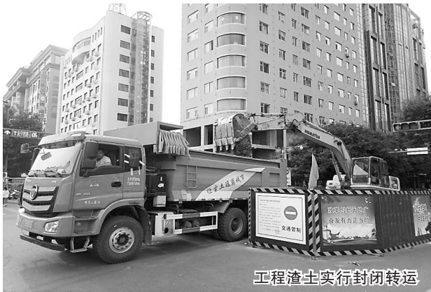
工程渣土实行封闭转运
