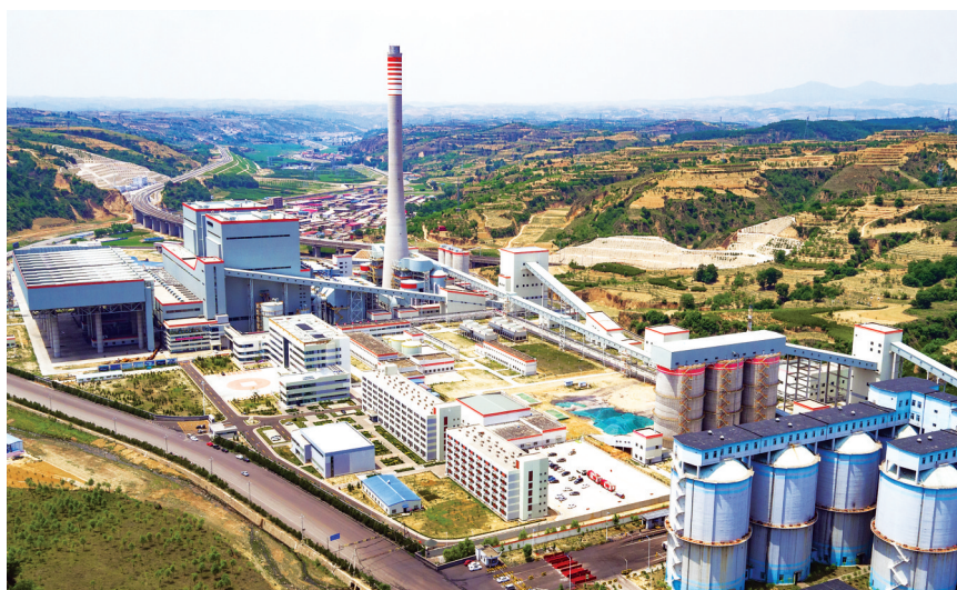
山西京能吕梁发电有限公司位于临县城庄镇,项目总投资为6.2亿元,目前正处于系统调试阶段,投产后年可发电35亿千瓦时,产值约3.5亿元,可提供就业岗位300余个。记者 刘亮亮 摄
