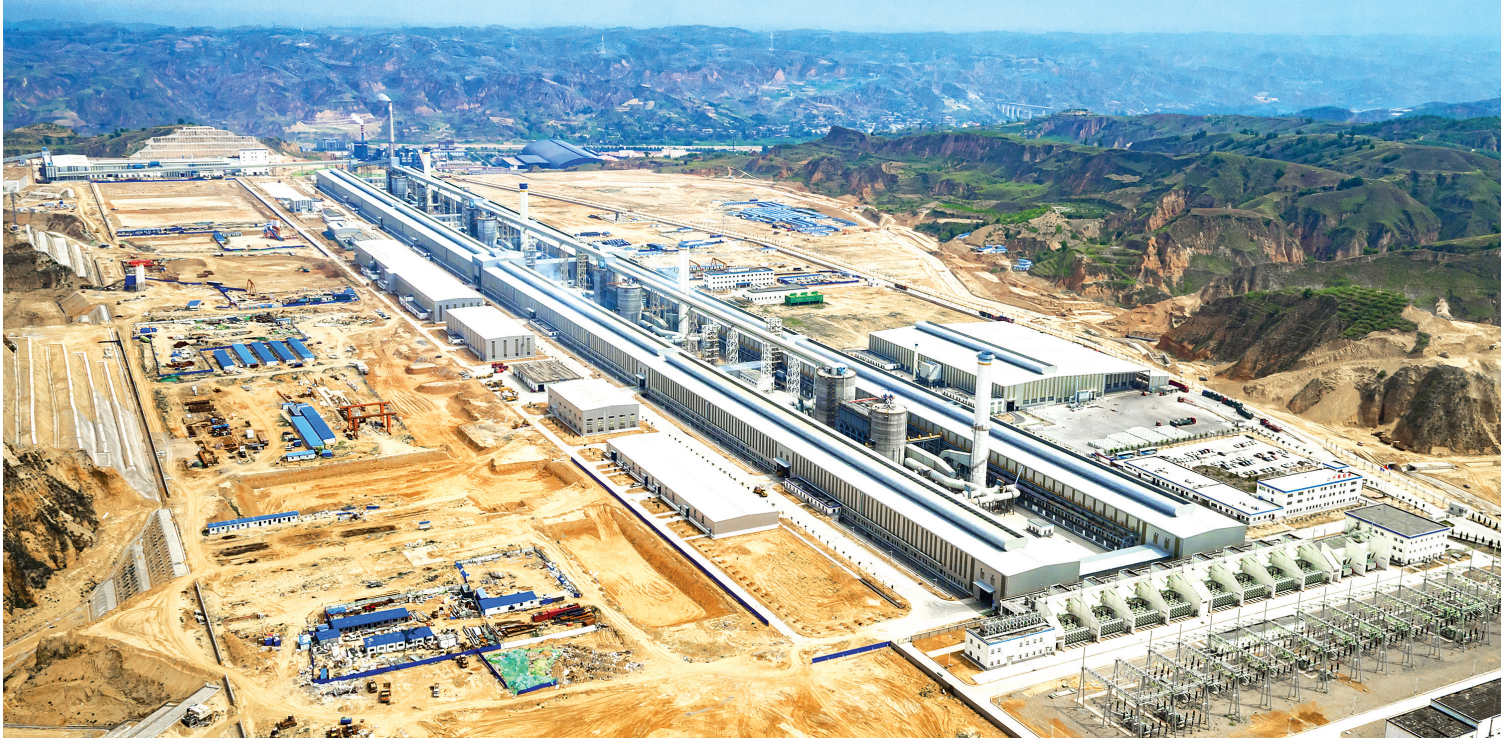
山西中润一期43.2万吨电解铝项目采用国内先进的节能型电解槽368台,干法电解烟气净化系统4套,配套阳极组装和铸造车间等,2018年生产铝锭5.3万吨。总规划建设100万吨合金铝和3×660MW自备电厂,目前项目已全部建成。 记者 刘亮亮 摄
