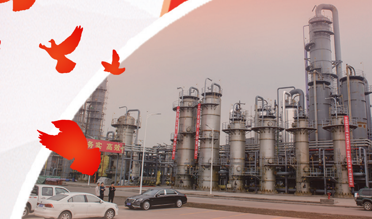
山西润锦化工有限公司焦炉煤气综合利用多联产项目
