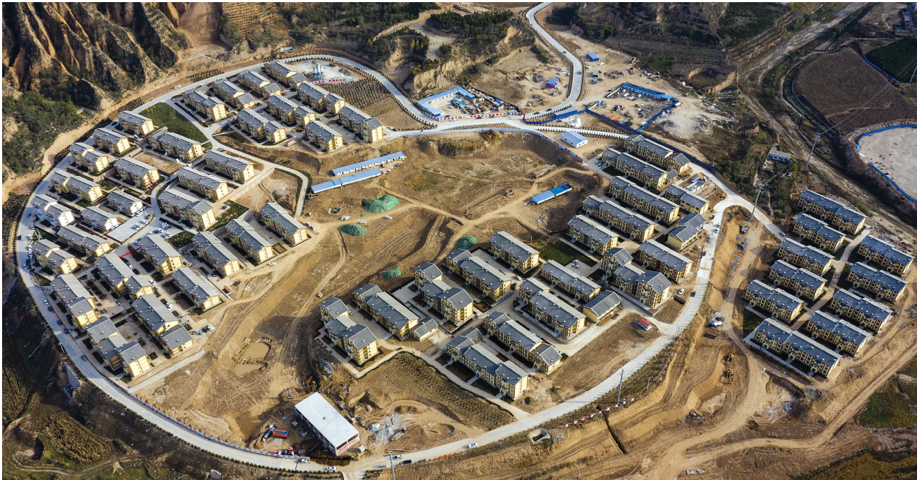
10月31日,无人机拍摄的石楼县易地扶贫搬迁项目。石楼县易地扶贫搬迁项目位于灵泉镇,项目规划总用地面积460亩,总建筑面积110859㎡,建设有86栋多层住宅楼,2处三层幼儿园,可安置贫困户1348户4324口人。
