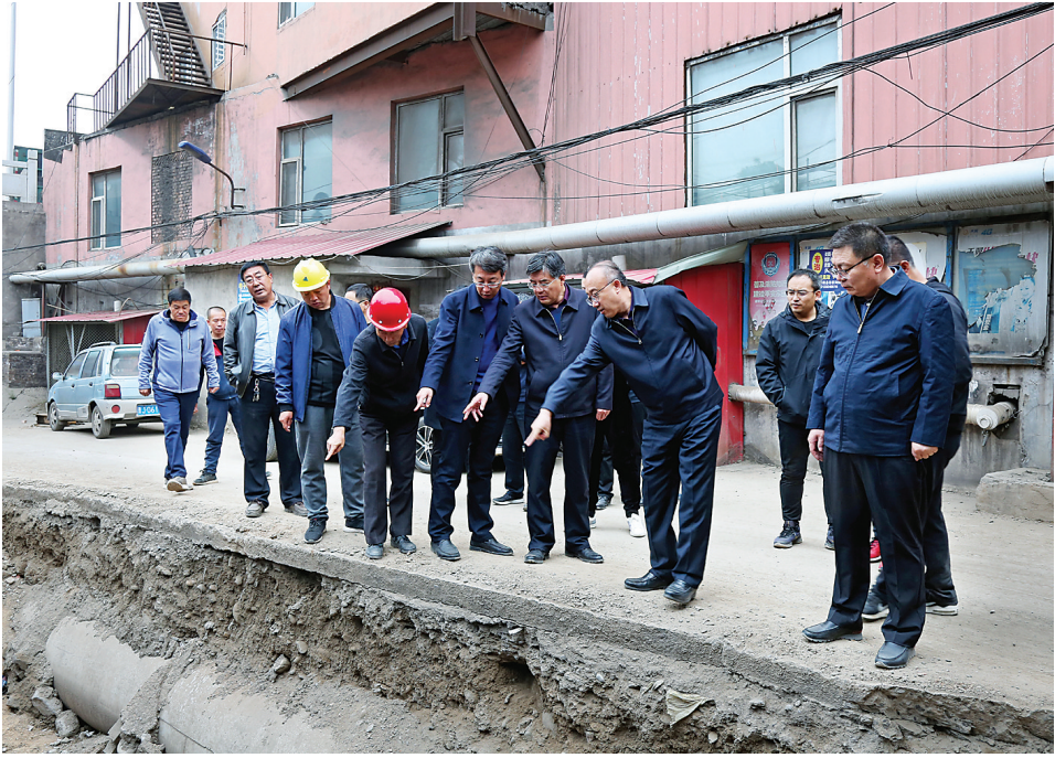
了解磁窑会供热管道铺设进展情况。 张旭峰 摄
