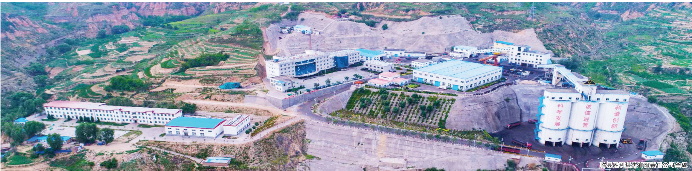
临县胜利煤焦有限责任公司全貌
