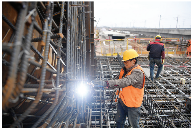
1月1日,中铁四局工人在引江济淮沪蓉铁路改建工程施工现场作业。
