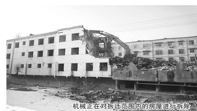
机械正在对拆迁范围内的房屋进行拆除
