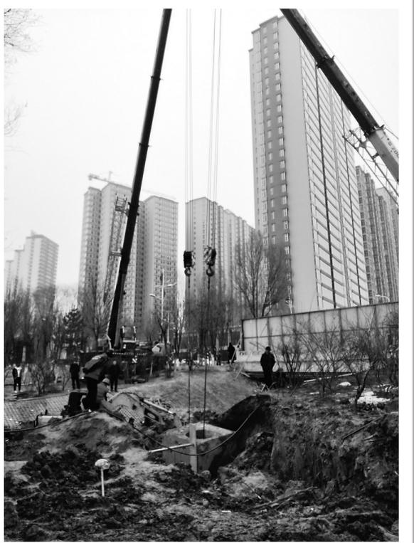
2月1日,记者在市区北川河公园王家沟段现场看到,供水公司的工作人员正在用抽水机往外抽水,工作人员对跑水点进行围挡,对跑水点进行开挖作业。一位供水公司的工作人员称,这儿发生水管爆裂之后,他们第一时间赶到现场,首先得把井盖下方的水抽干,等确定跑水点位置之后,会把地面挖开,进行抢修,尽快恢复供水。施工现场,工作人员顾不上休息,除了挖掘机司机小心地操作着机械臂探挖之外,时间已临近晚上,抢修现场依旧热火朝天,有的工作人员拿着照明工具照亮现场,还有的拿着辅助工具配合挖掘机加快挖掘进度。 记者 郭炳中 摄
