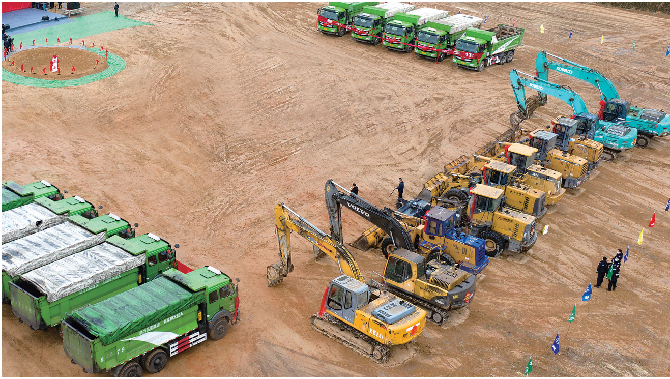
图为吕梁经济技术开发区项目开工现场。
