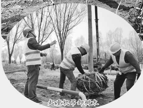
起重吊吊卸树木
