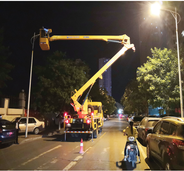
6月3日,工人在维修市区文景路路灯。市区路灯管理部门积极做好城区照明设施维护管理工作,加强城区道路照明设施的维修维护工作,切实保障城区照明设施安全稳定运行。记者 郭炳中 摄
