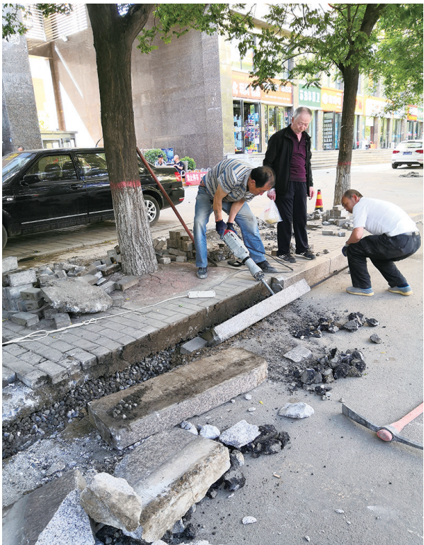
6月2日,工人们在市区凤山路进行替换路沿石施工。连日来,中心城市风貌整治、添绿添彩提档工作正在加紧施工。记者 郭炳中 摄
