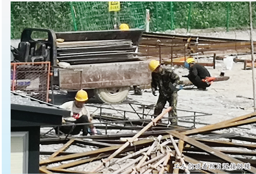
工人们顶着烈日焊接钢梁
