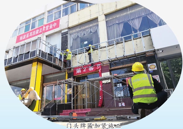
门头牌匾加紧施工
