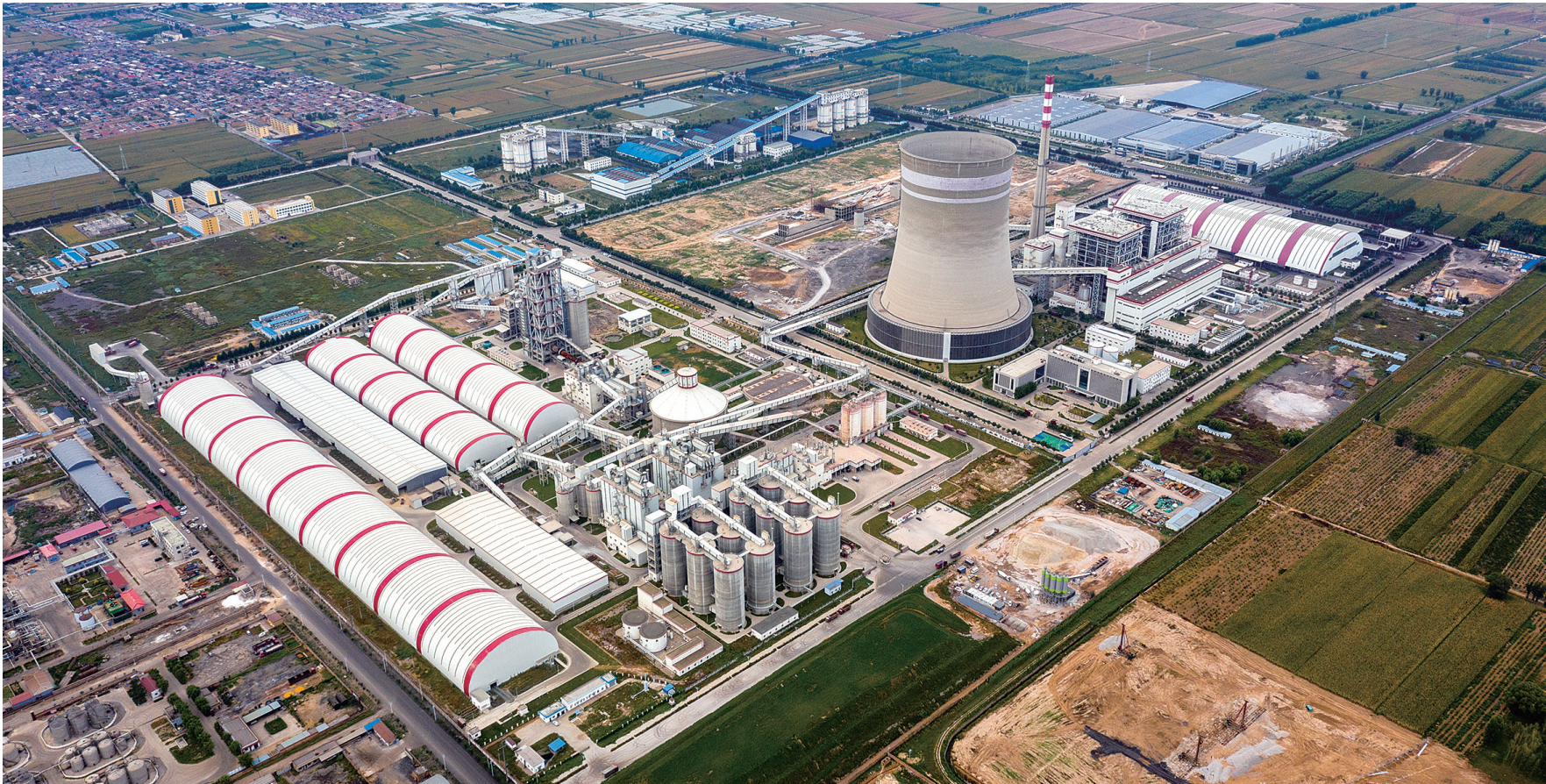
变废为宝 昔日发电灰渣成垃圾,如今固废“摇身”变水泥。转型循环产业项目山西国金电力有限公司固废综合利用工程采用新型干法预分解窑生产线,通过配套9MW纯低温余热发电,选用高精度煤粉计量秤和多通道喷煤管等设备,将电厂发电产生的固废灰渣转化为年产200万吨水泥,该工程同时可处理城市垃圾及危险废弃物,具有良好的社会效益、经济效益和环保效益。 记者 刘亮亮 摄
