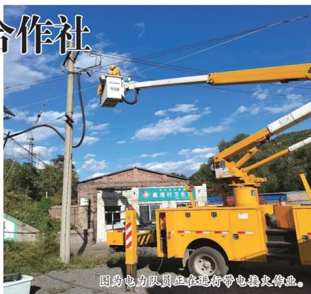
图为电力队员正在进行带电接火作业。
