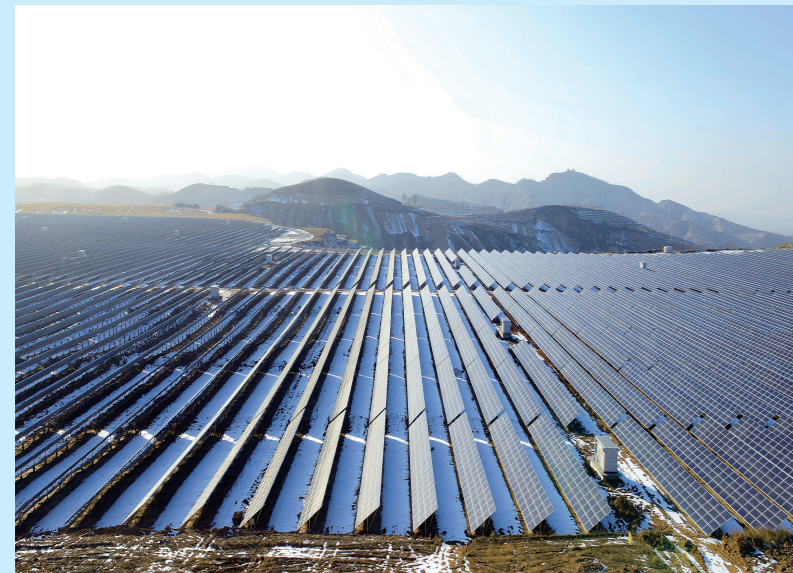
光伏投资——图为方山县大武镇光伏发电项目。
