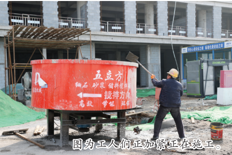
图为工人们正加紧正在施工。
