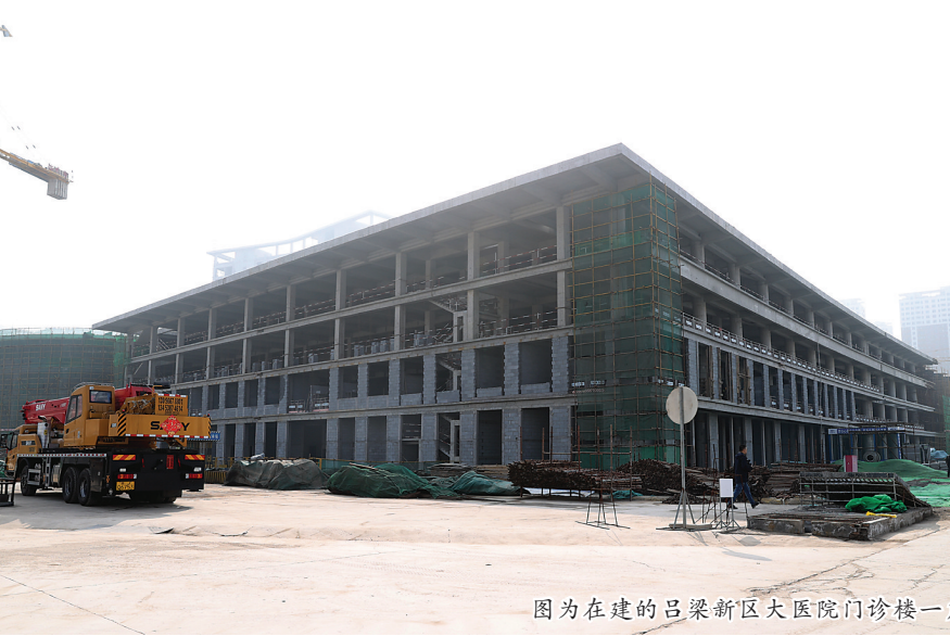
图为在建的吕梁新区大医院门诊楼一角
