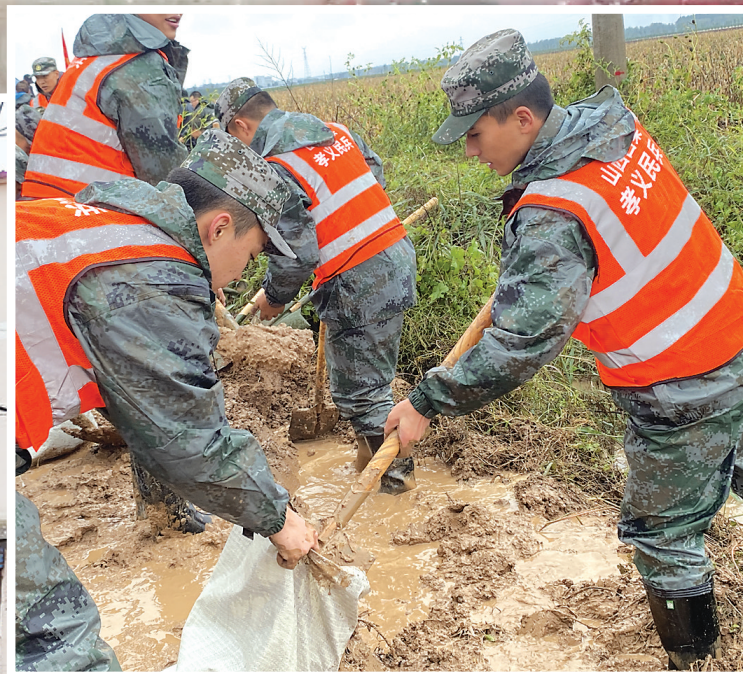
孝义民兵应急连对沿岸堤坝加固
