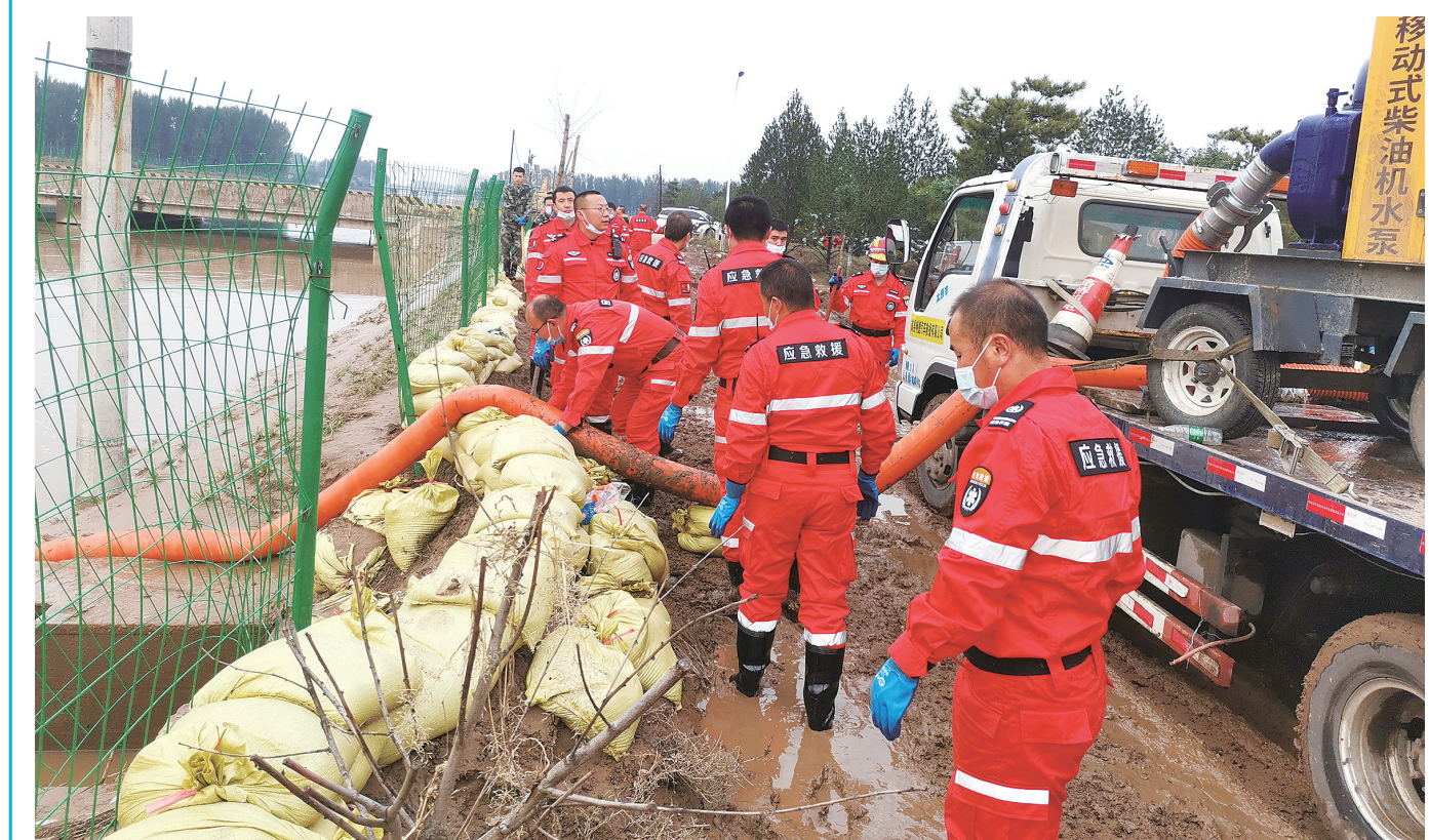
10月11日,岚县综合应急救援大队赶赴指定排洪抢险点孝义市孝介大道五楼庄节制闸河道,全力以赴支援抢险救灾工作。38名应急救援队员驾驶10台应急救援车辆,拉着300立方柴油水泵1台、30KW柴油发电机2台等设备和应急物资,奔赴指定位置开展排洪抢险作业。截至目前,排水量达12000余立方米,全力守护了孝义市人民群众生命财产安全。尹瑞平 摄
