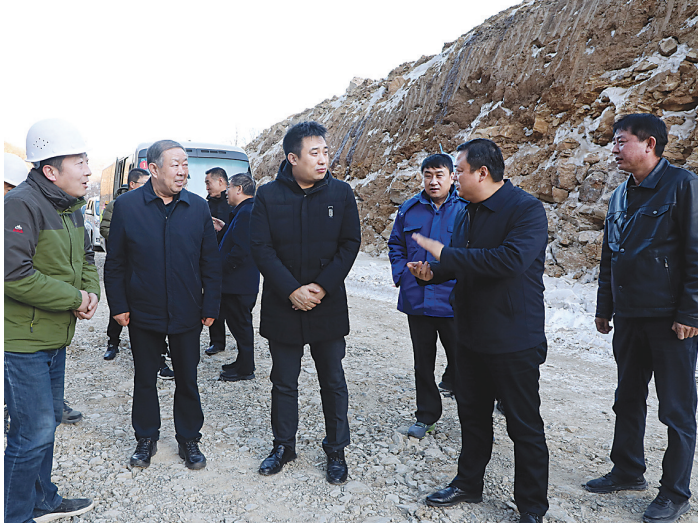
暖泉镇11万伏变电站项目现场。
