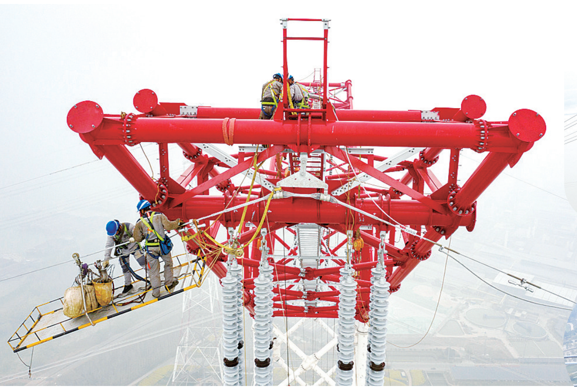
3月14日,在安徽芜湖的长江边,安徽送变电工程有限公司施工人员在高空进行特高压输电线路跨江作业(无人机照片)。
