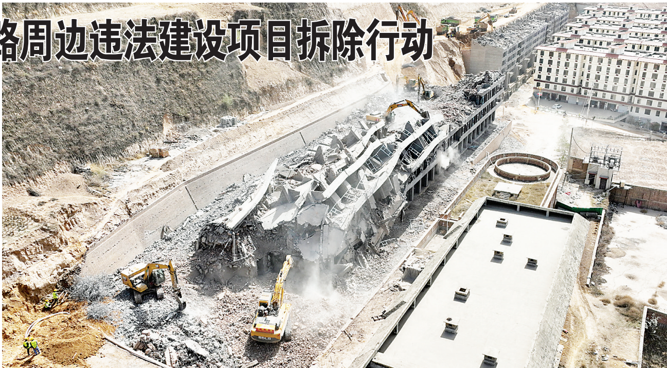
图为文丰路红旗苑违法建筑拆除现场。
