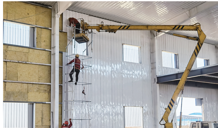
建设中的西营镇城头村年产8000吨沙棘果饮料生产线
