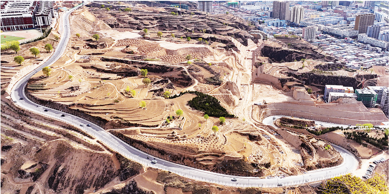
近年来,我市依托市区三山环抱、三川环绕的地理优势,充分利用凤山区域山川秀美、景色壮丽的环境优势,加快推进凤山循环路工程建设,全力打造“最美旅游环线”,着力提升城市品质。图为无人机拍摄的风山循环路一角。
