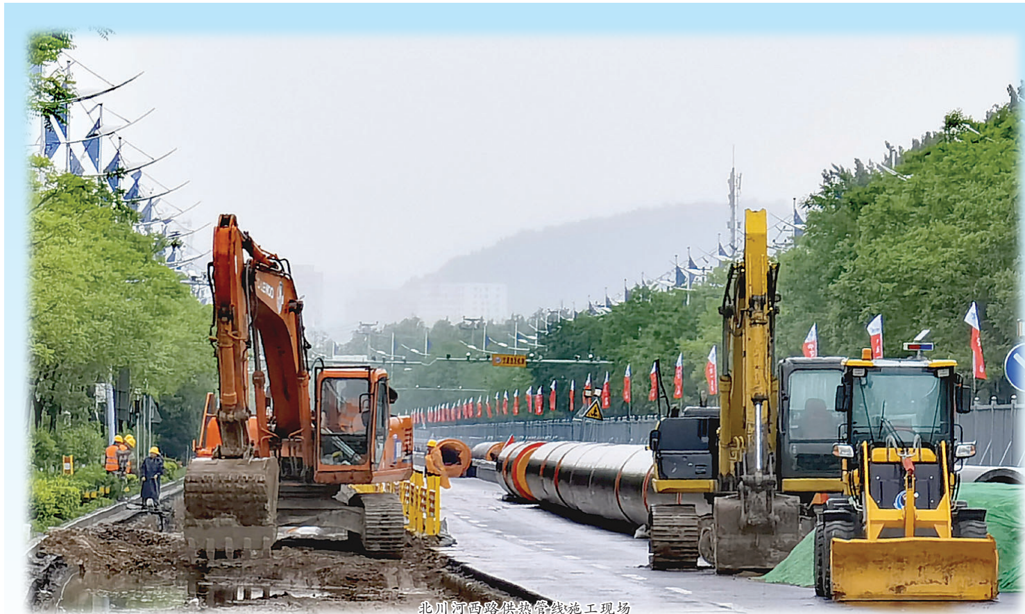
北川河西路供热管线施工现场
