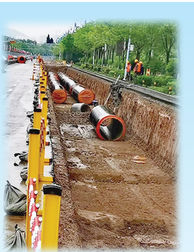
开挖直埋的管沟
