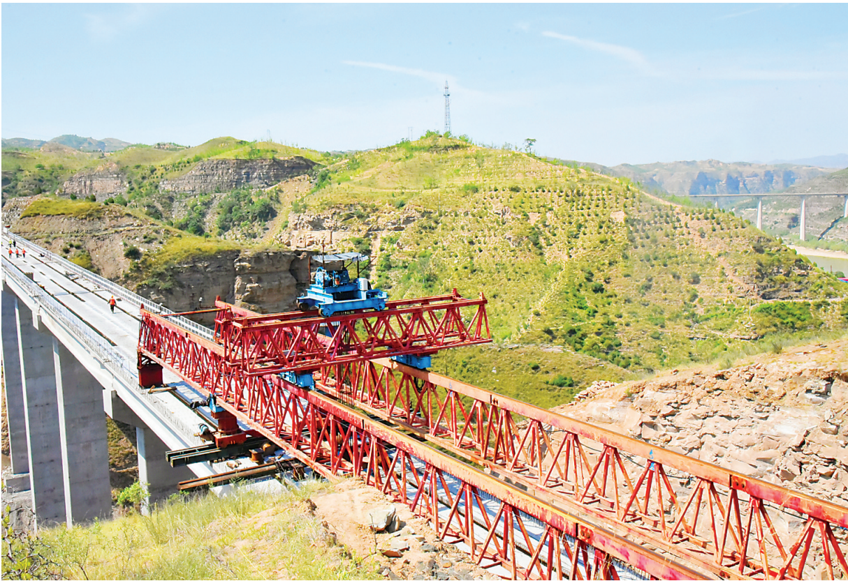
随着最后一块钢筋混凝土T梁安放到位，黄河一号旅游公路石楼段首座大桥(辛关大桥)顺利贯通。 许文悦 摄
