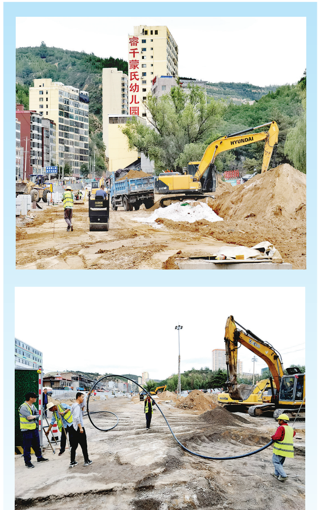
连日来,吕梁新区快速路项目——文丰路拓宽改造工程现场机声隆隆,工人们干劲十足,抢时间、抢进度,快马加鞭,按下市区重点工程建设“快捷键”,项目建设紧锣密鼓有序推进。
