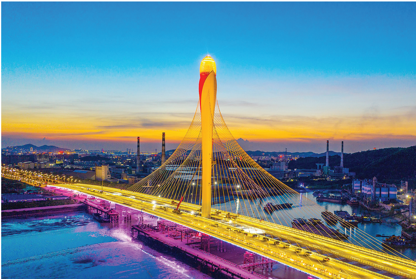
夜幕下的东莞滨海湾大桥(6月28日摄，无人机照片)。
