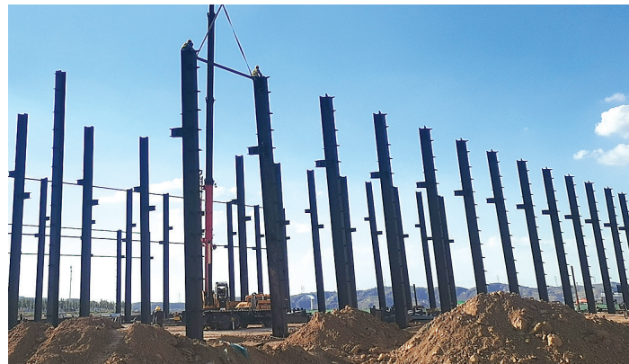
兴县经济技术开发区以打造千亿级铝镁新材料产业园区为目标,进一步推动产业链向下游延伸,价值链向高端迈进,最终实现产业高端化、能源低碳化、产品绿色化和生产数字化。图为现场施工照。张娟娟 摄
