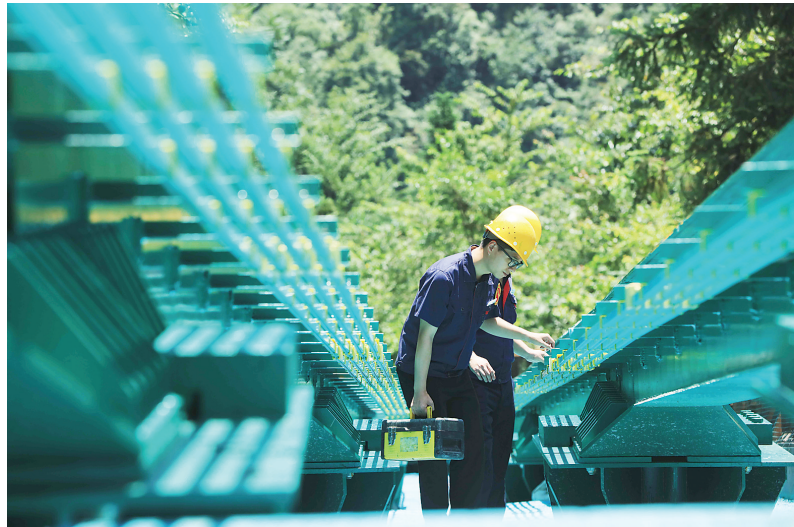
7月26日，在张家界市武陵源景区，工作人员对观光电车轨道进行安全检查。 进入暑期旅游旺季以来，湖南省张家界市武陵源景区在做好疫情防控的基础上，加大对景区内高空客运索道、观光电车等配套设施的安全隐患排查力度，保障游客安全。 新华社发 吴勇兵 摄
