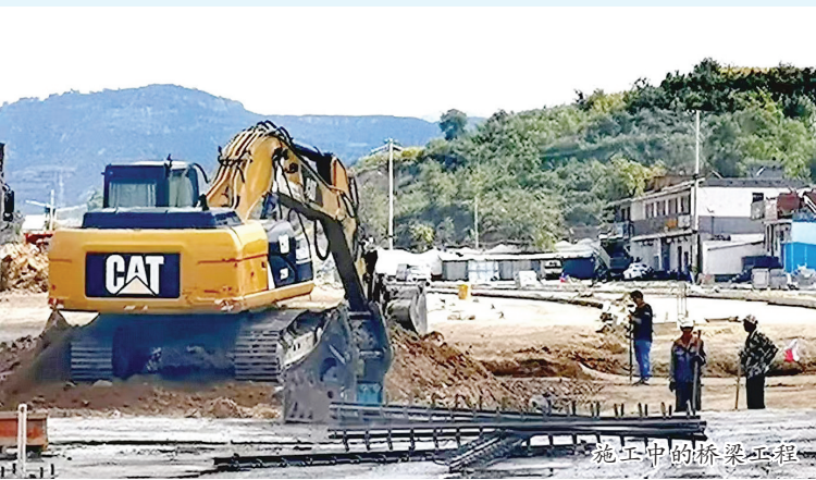
施工中的桥梁工程
