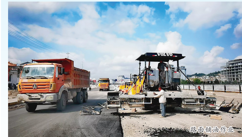
路面铺油作业
