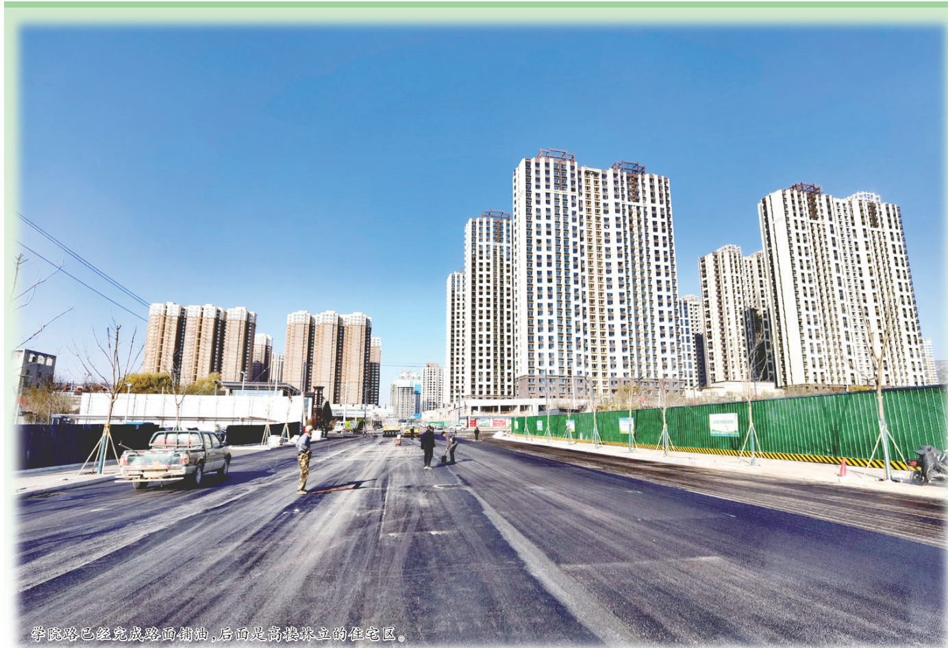
学院路已经完成路面铺油,后面是高楼林立的住宅区。
