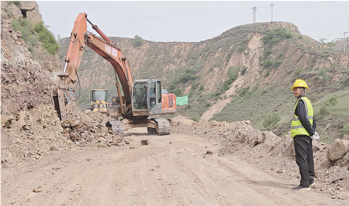
图为正在紧张施工中的贺家湾到段家塔公路现场。刘沛林 摄
