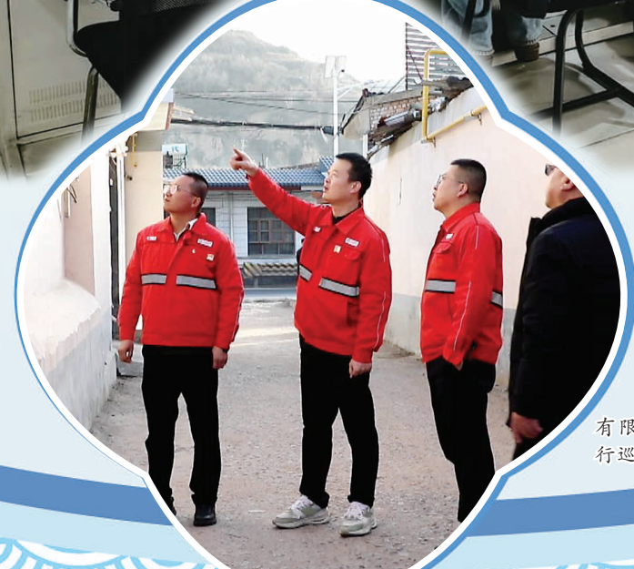
兴县华盛燃气有限公司技术人员冒着严寒在施工现场工作。
