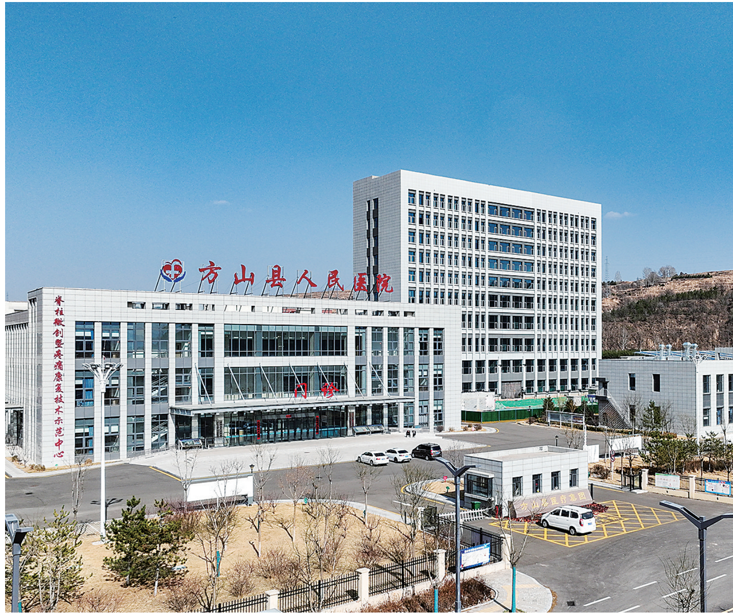
连日来，方山县人民医院新建院区持续推进投运工作。据介绍，该新建院区配套设施逐步完善，重点建设脊柱微创暨疼痛康复技术示范中心。目前部分科室已顺利搬迁投用，新院区启用后将持续优化服务流程，全面提升县域诊疗能力，切实改善群众就医体验，为方山及周边群众提供更优质便捷的医疗服务。
