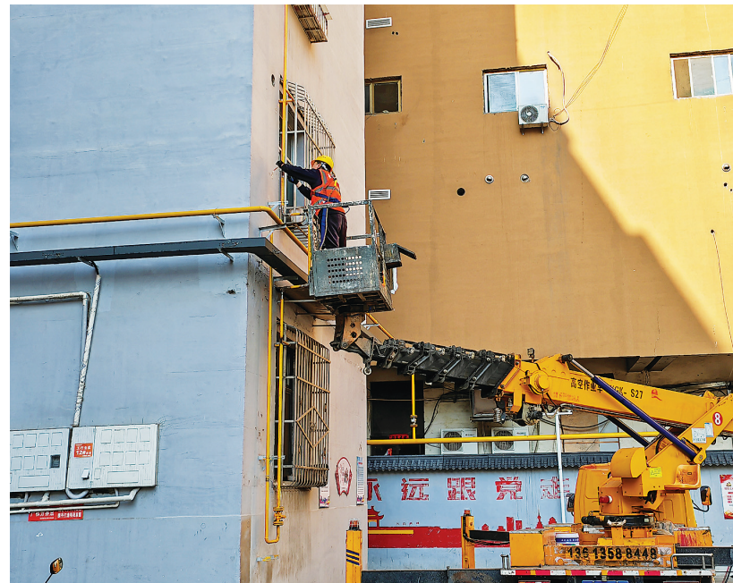
连日来,市区老旧小区燃气改造工程正在有序推进中。图为在久安路行小区内,施工人员身着安全装备,对已安装到位的燃气管道开展刷漆工作。 记者 王洋 摄
