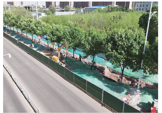
供水管网改造施工现场 罗丽 摄
