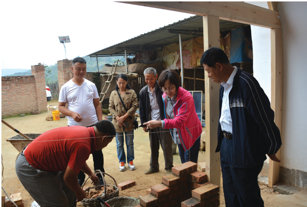
查看危房改造工程进展情况 王耀摄
