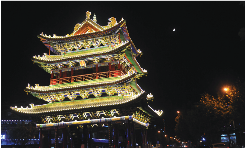
南薰楼,位于汾阳市南薰街道南关社区。建于明弘治十三年(1500年),占地约100平方米,高17.26米,现为汾阳市重点文物保护单位。今年,汾阳市对南薰楼进行保护性修缮,现已完工,重现雄伟壮观气势。图为南薰楼漂亮夜景。 李勇斌 摄
