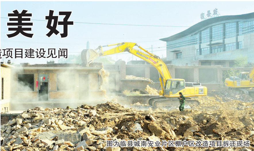
图为临县城南安业片区棚户区改造项目拆迁现场
