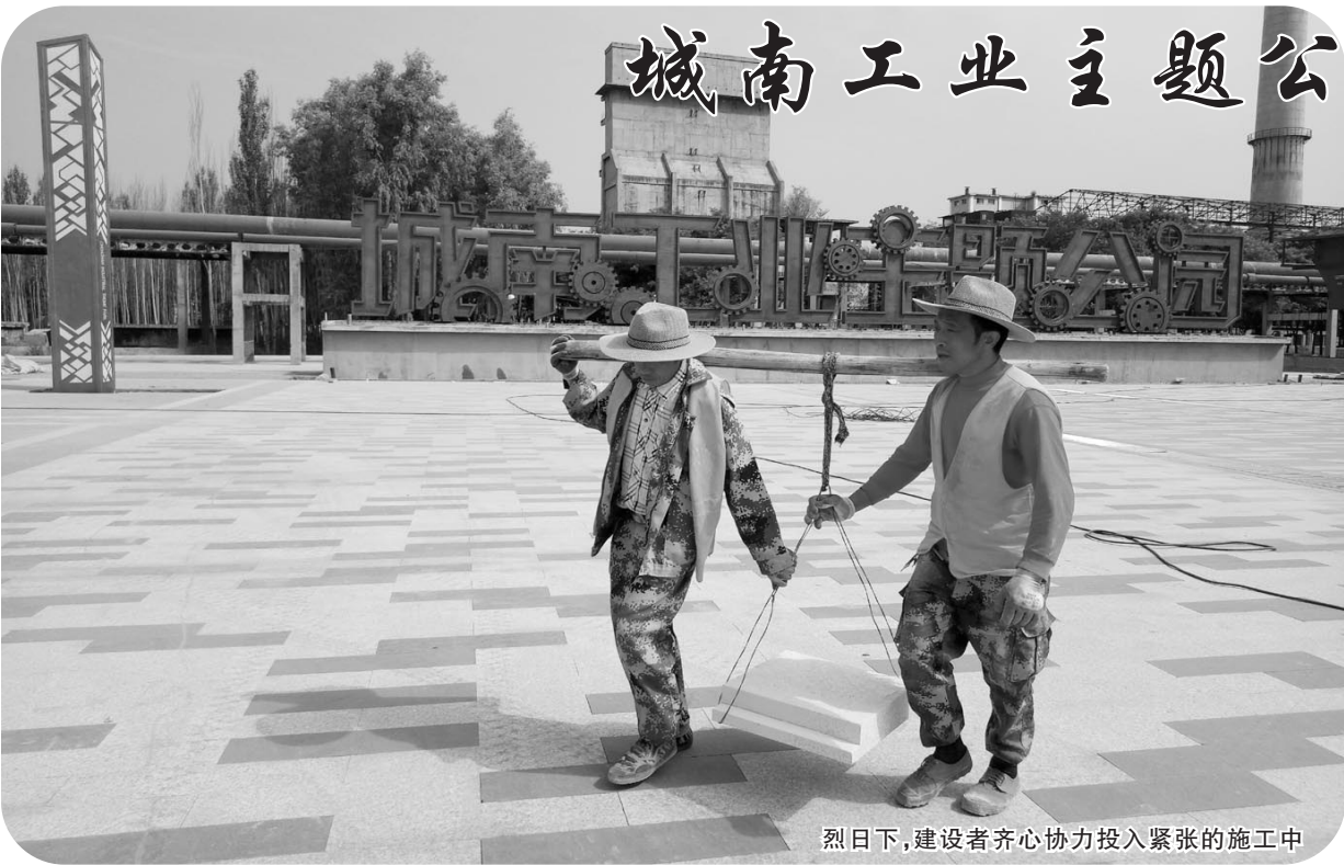
烈日下，建设者齐心协力投入紧张的施工中
