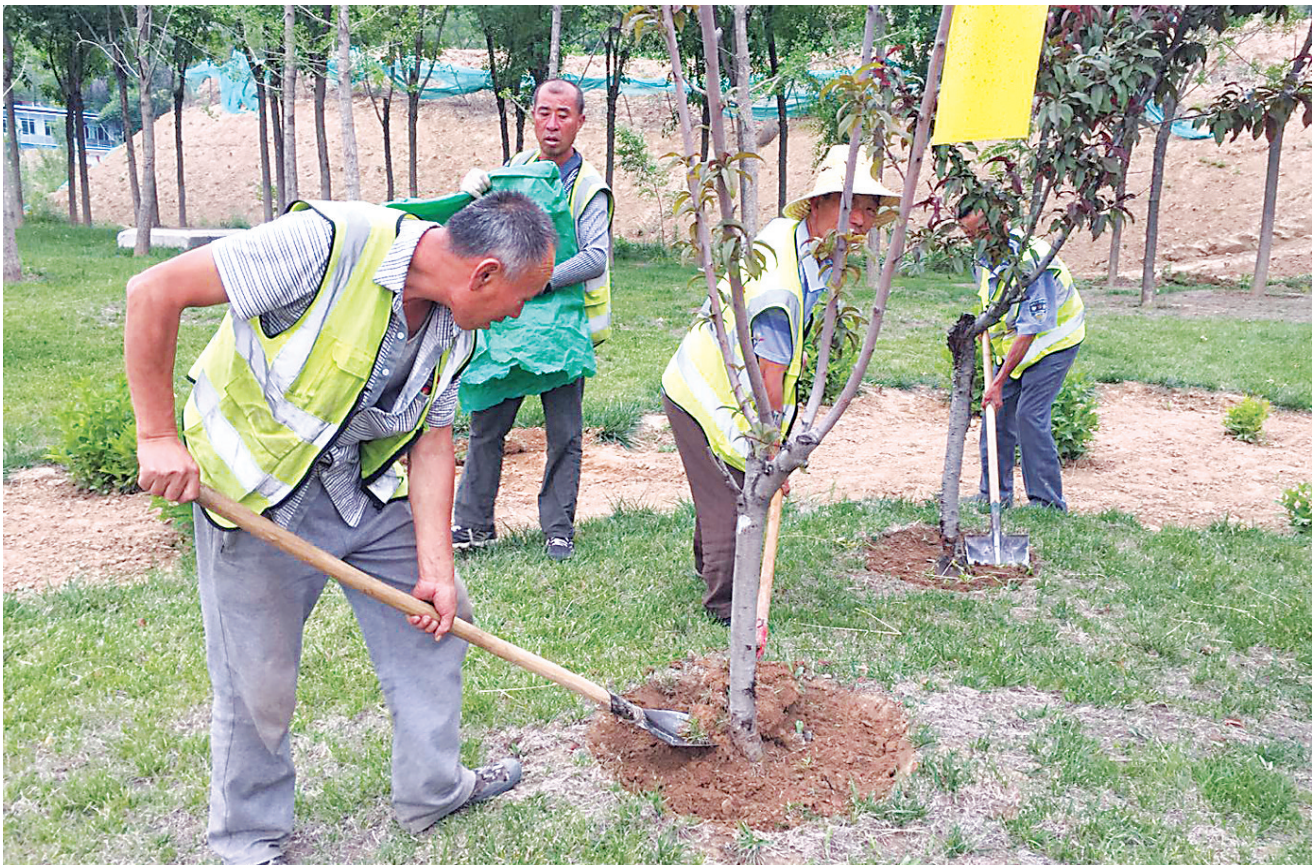
近年来,吕梁大道沿线的绿化、美化、彩化工程已初见成效,新区绿化带主要通过高低错层、套种红、黄、绿颜色不同的树种,同时加大对绿化带内裸露土地实行横到边、竖到沿、拉网式的补植工作,在面积较大的裸露土地种植草坪,消除绿化死角,使得新城区道路绿化效果全方位提升。图为工作人员在为树挖坑。 王燕华 摄
